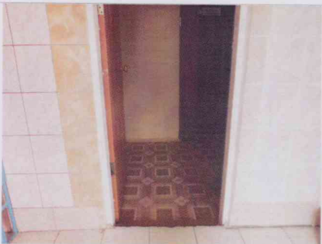
Фото №23 – Пути движения внутри здания (двери)
