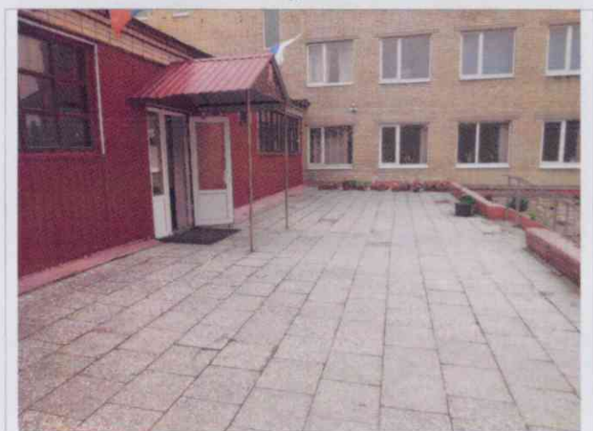
Фото №5 – Входная площадка главного входа
