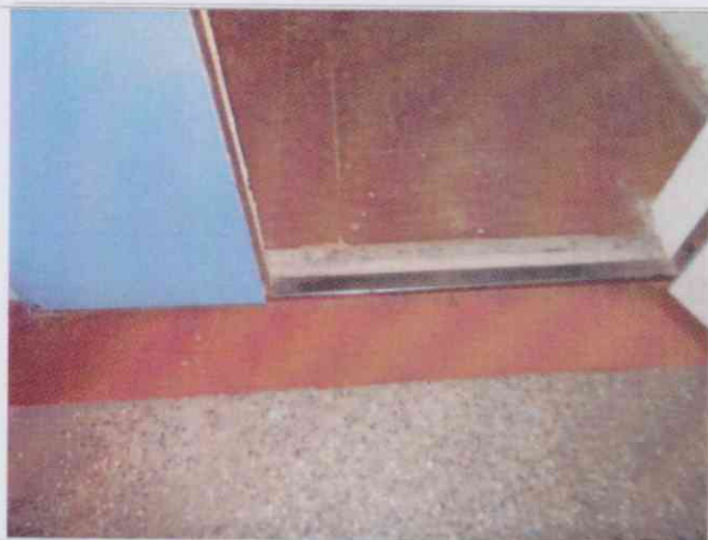
Фото №21– Пути движения внутри здания (двери)
