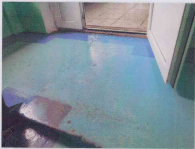
Фото №19 – Пути движения внутри здания (двери)
