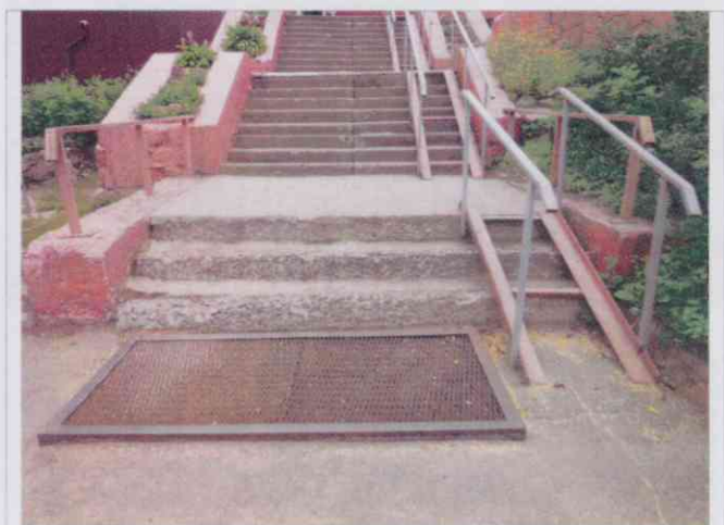
Фото №3 – Наружная лестница
