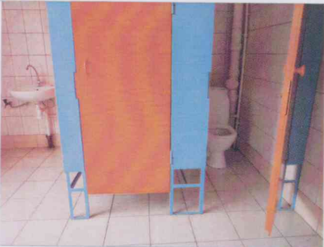
Фото №33 – Санитарно-гигиеническое помещение (туалетная кабина)
