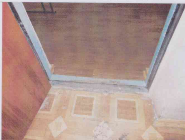
Фото №24 – Пути движения внутри здания (двери)
