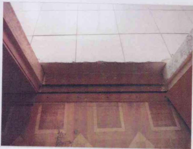
Фото №25 – Пути движения внутри здания (двери)
