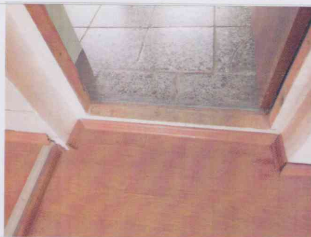
Фото №22 – Пути движения внутри здания (двери)
