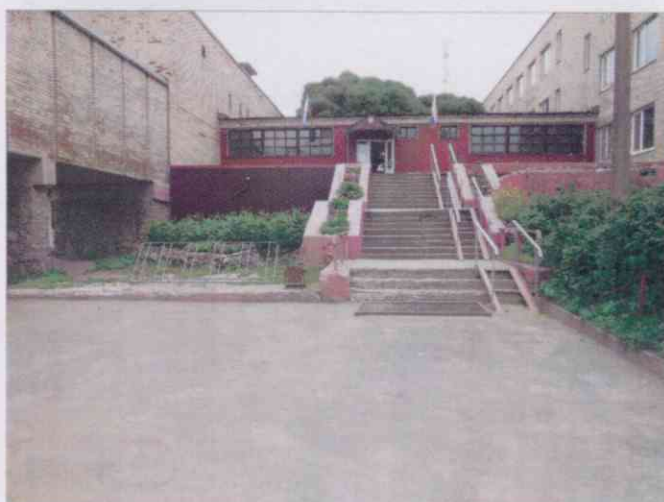
Фото №2 – Подходы к объекту
