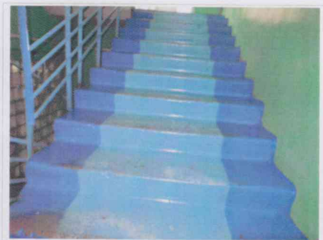
Фото №16 – Пути движения внутри здания (лестницы)
