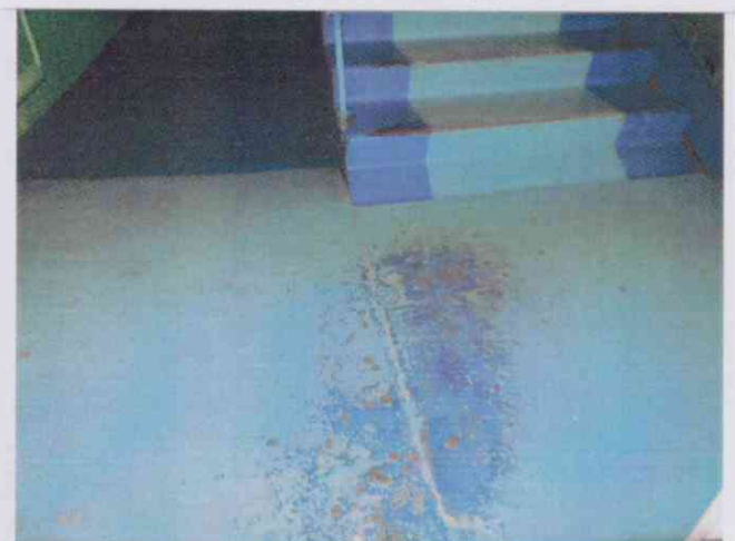
Фото №17 – Пути движения внутри здания (лестницы)
