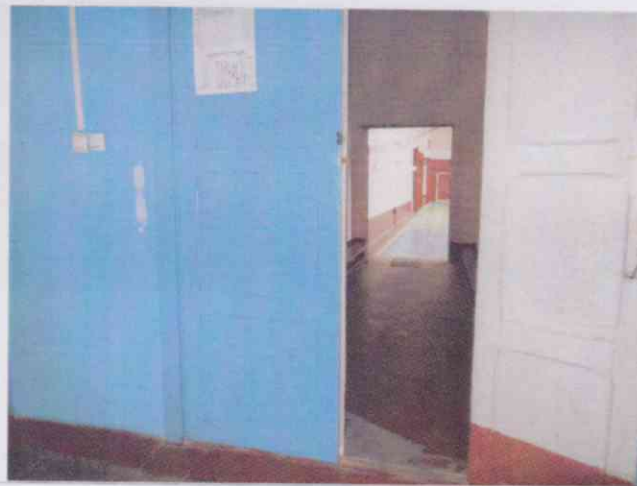
Фото №20 - Пути движения внутри здания (двери)
