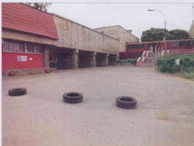
Фото №1 – Подходы к объекту
